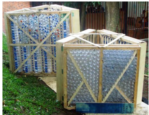
Fig.10 Marcos de madera tratada rellenos de botellas de PET reciclado. Fuente: Taller con alumnos de Arquitectura dirigidos por L. Rodríguez
