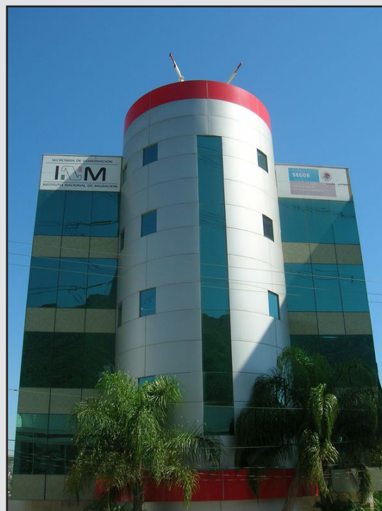
Foto 7-3 Fachada de la Estancia Provisional de Nuevo León
