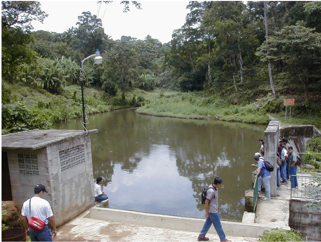
Pequeño embalse de la PCH Nahuizalco en el dique del río Sensunapán
