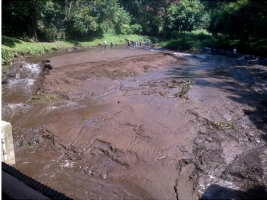
Embalse del dique, habiéndose abierto la compuerta de fondo para desalojar el material decantado
