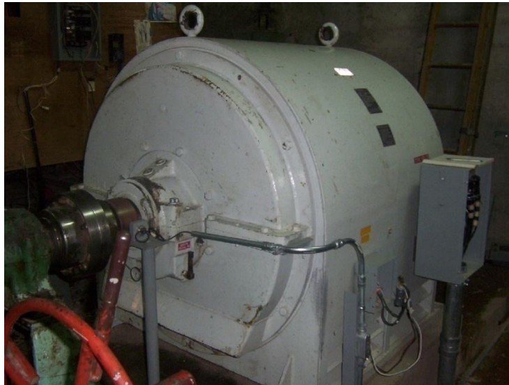
Unidad Turbina Hidráulica-Generador de la PCH La Calera, propiedad de la Sociedad “De Matheu y Cía S.A. de C.V.”
