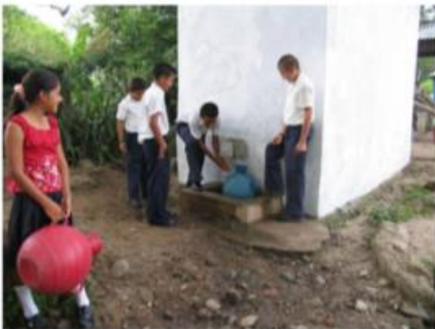
Sistema de Cloración Comunidad Nueva Esperanza
