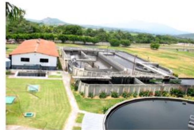
Planta de Tratamiento en Planta Nixapa
