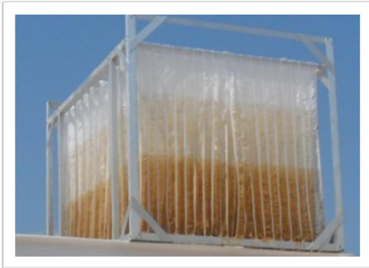
Fotografía 2: Reactor de lodos Activados de Película Fija.
