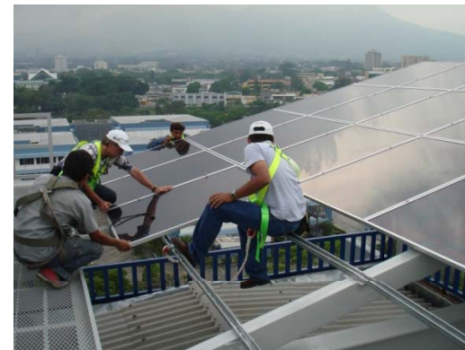
Inclinación de los paneles: 15^\circ orientados hacia el sur
