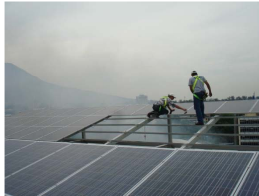
Montaje de la paneles fotovoltaicos
